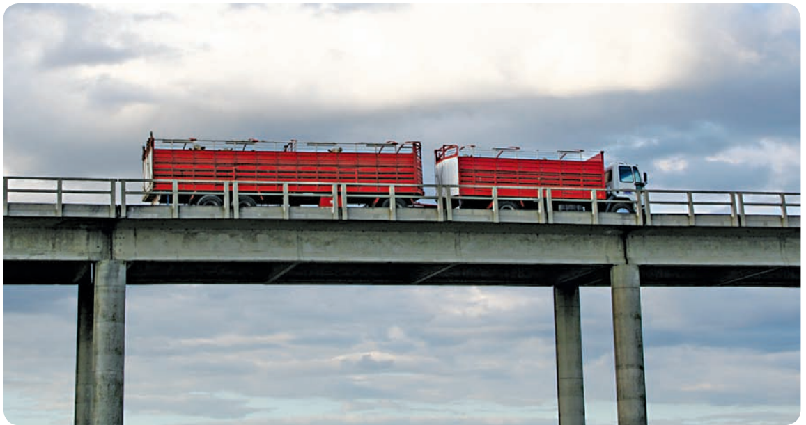
Puente sobre el río Uruguay.
