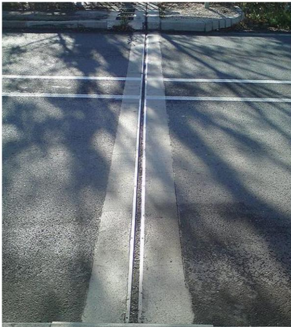
Junta de dilatación y junta de vía del tren.
