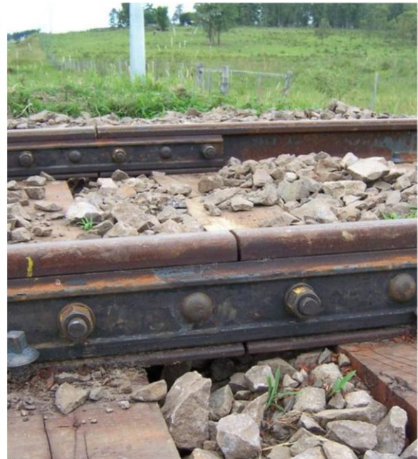
Junta de dilatación y junta de vía del tren.
